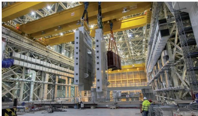
Transfert des ponts roulants 750 T et d'essais en charge du nouveau bâtiment du Tokamak sur le site d'ITER.
